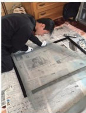
止めがかかっているの、外れ止めを解除してから外します。外したら、古い網を取り除き、雑巾で綺麗に拭きます。そして新しい網を張っていくのですが、網の保管状況が悪く、網に型が付いてしまっていました…。お客様からの仕事であれば、網を新しい物に取り替えますが、自宅にあった網が1セット分しか無かった為、そのまま張ってしまいました。写真では、綺麗に見えますが、実際は網に型が付いていて、ヨレヨレです…。しかし、「網戸が無いよりはまし
